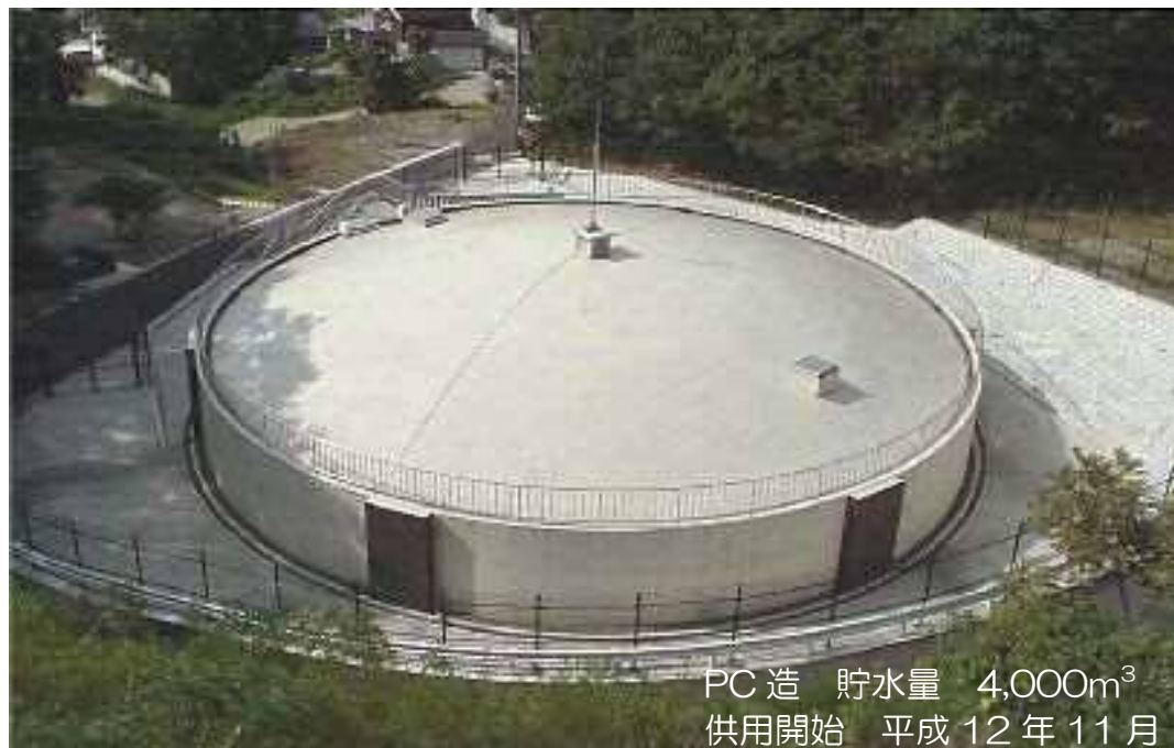
中之町基幹配水池
