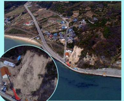
国道185号 幸崎町 崖崩れ
