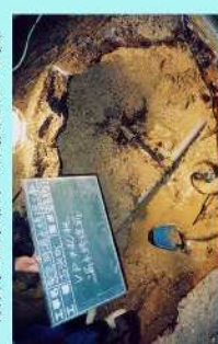
沼田東町釜山 鋼管φ200 継手 破損
