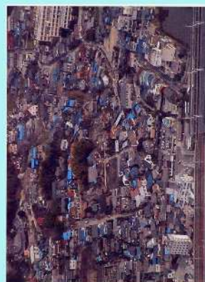
三原駅北側付近 プルシートで屋根を覆う家屋
